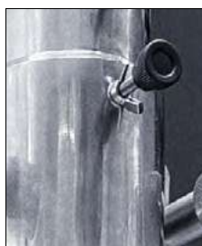
DETALHE MANÍPULO DE FIXAÇÃO DO TAMPÃO
